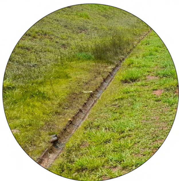
Canaletas da drenagem superficial da barragem Serra Azul com manutenção em dia, em preparação para o período chuvoso.
