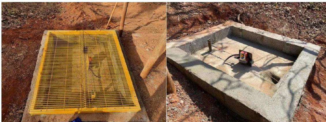
Imagem 7.1 – Caixa de ancoragem da chave de corda nas ombreiras da Barragem Serra Azul.
