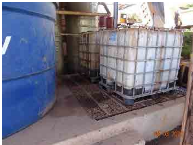
Figura 62 - Produtos para lavagem de veículos e caixa d'água de reuso
