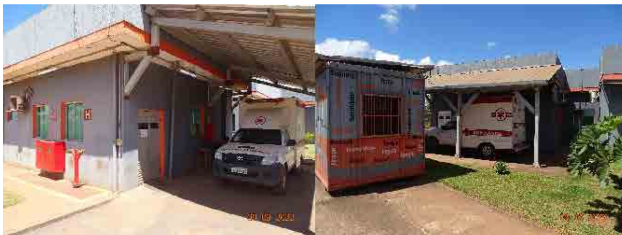
Figura 50 - Vista para ambulatório e contêiner de apoio a brigada de incêndio
