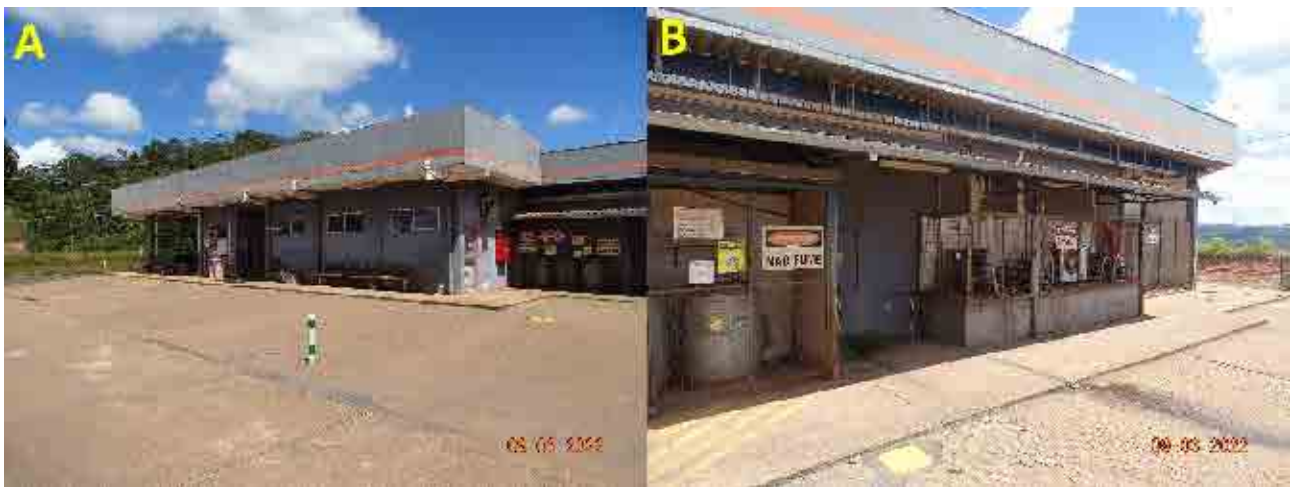
Figura 47 - A - Vista para restaurante. B – Vista para o painel elétrico e de equipamentos.
