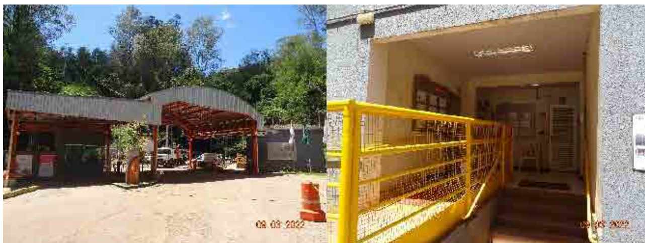
Figura 41 - Vista para portaria principal e área de apoio
