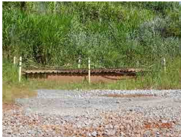
Figura 84 - Caixa SAO posto de combustível
