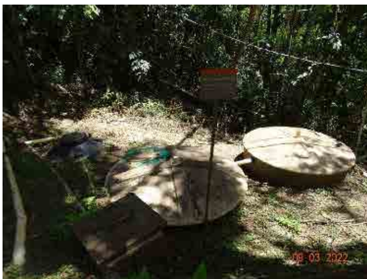
Figura 76 – Sistema Fossa Filtro Sumidouro da portaria principal
