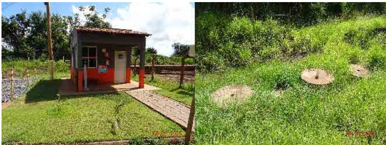
Figura 63 - Portaria do Posto de Combustível com fossa séptica
