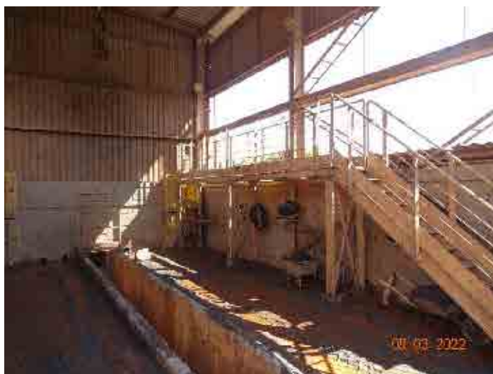
Figura 59 - Passarelas metálicas para proteção do operador
