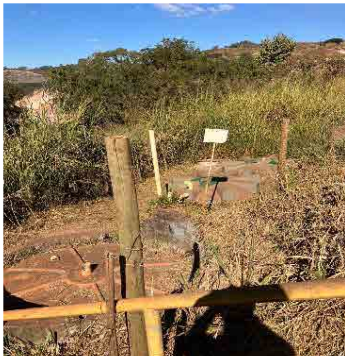
Figura 79 – Sistema Fossa Filtro Sumidouro da Oficina
