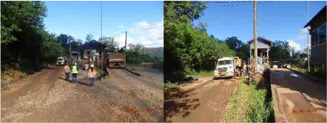
Figura 42 - Vista para portaria de 3 antas
