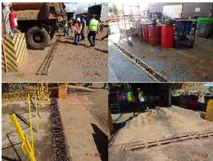
Figura 52 - Vista para rede de canaletas
