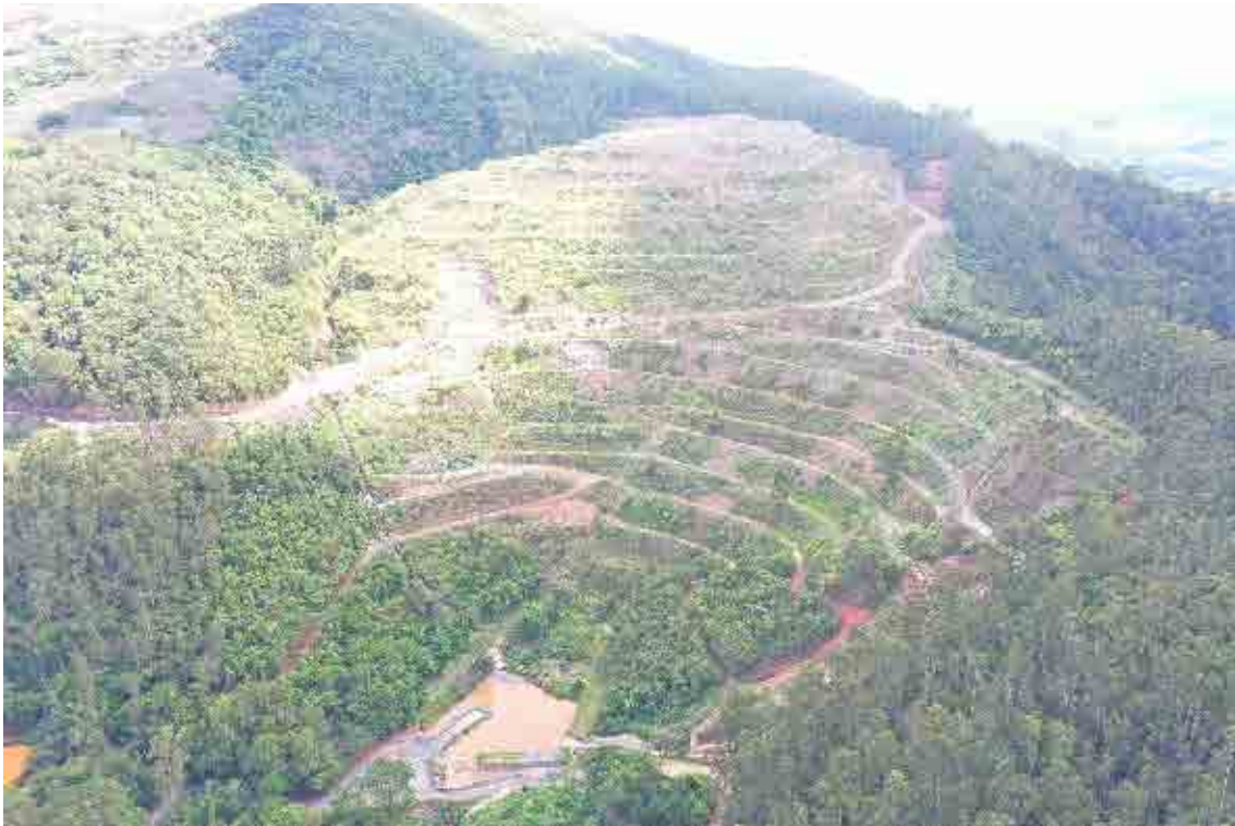
Figura 35 - Vista frontal da PDE 06
