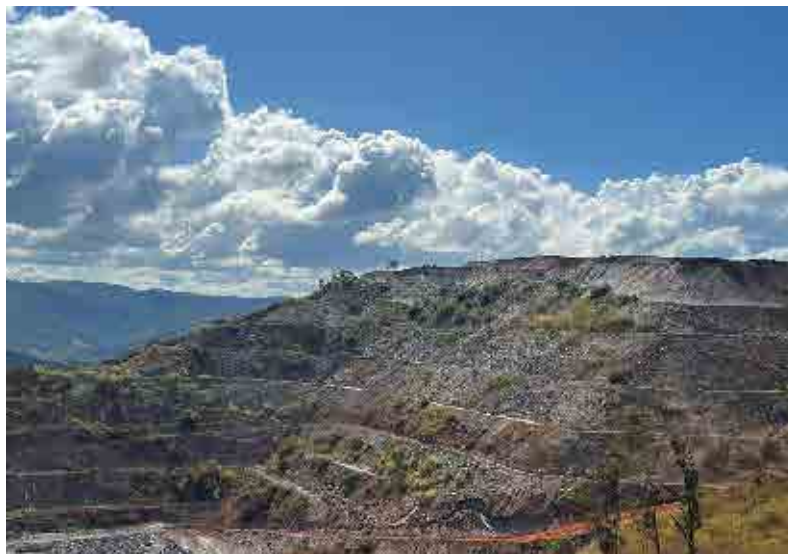
Figura 37 - Visão geral da PDE 08 – Aba Oeste, codisposição Itabirito/rejeito, Mina do Andrade
