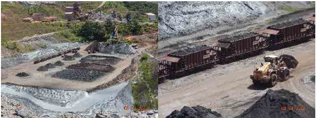
Figura 32 - Sistema de homogeneização e carregamento dos vagões
