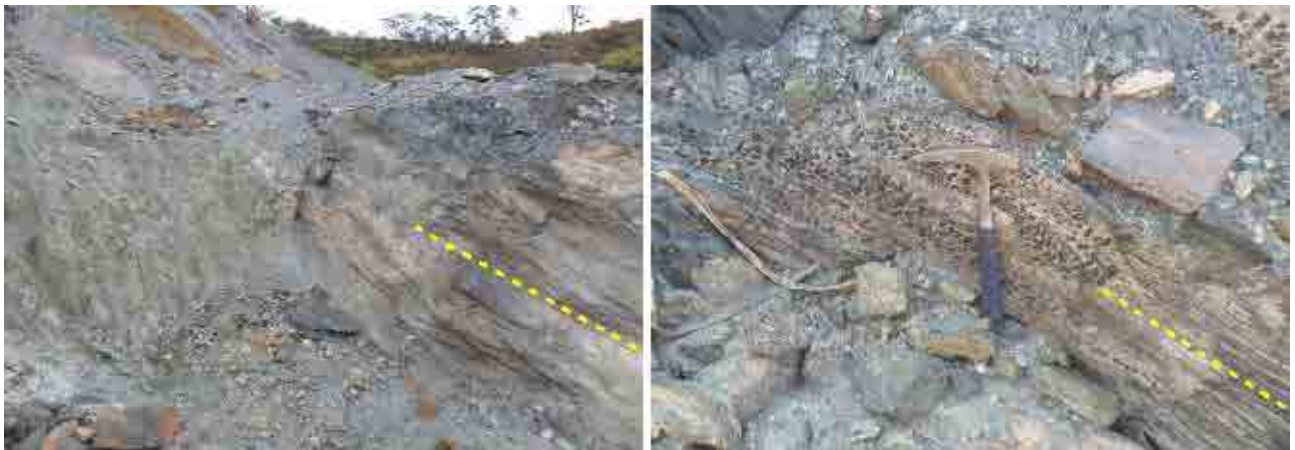
Figura 23 - Detalhe da intrusão de xisto ultramáfico com feições de movimento reverso (Fonte: VOGBR - B, 2013).
