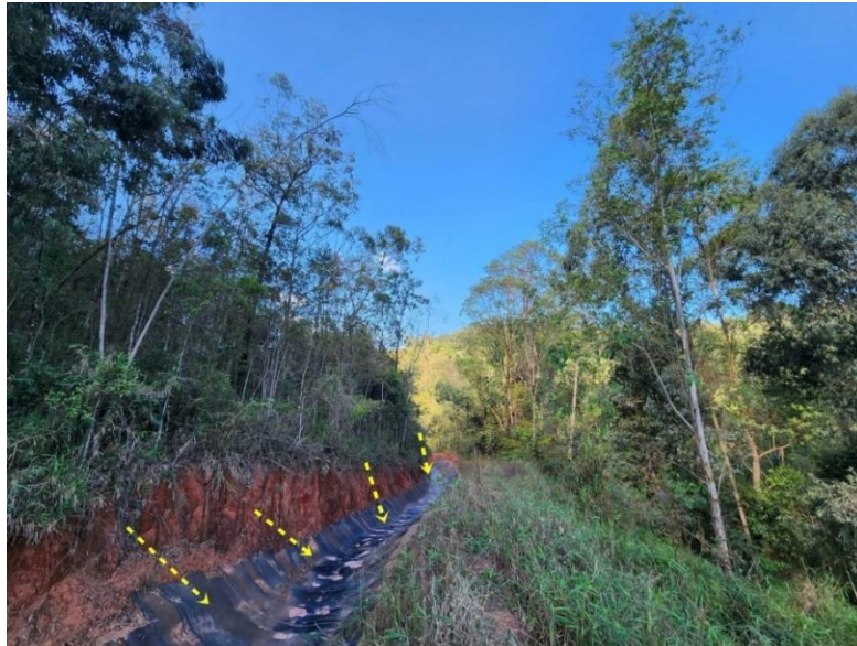
Figura 13: Utilização de correias transportadoras usadas para confecção de drenagem.
