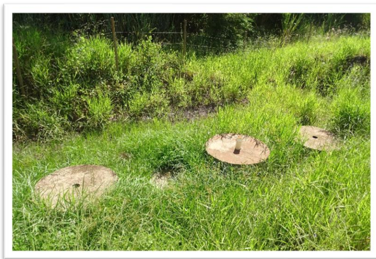
Figura 32 - Tratamento de Efluentes da Oficina
