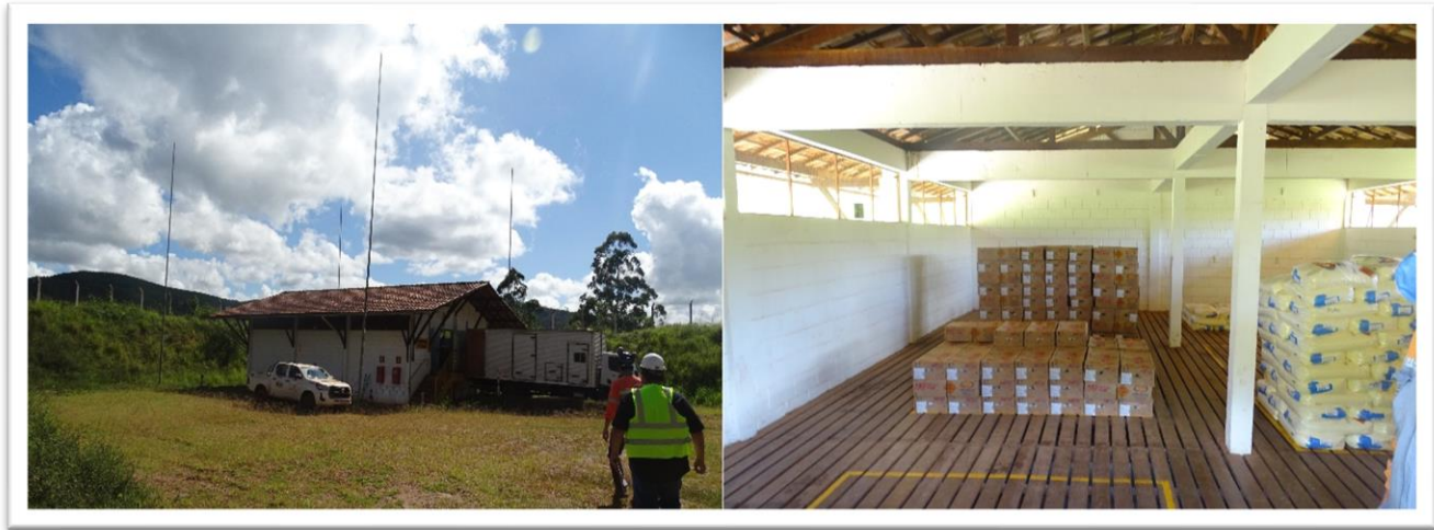
Figura 25 - Deposito 1 - Armazenamento de explosivos
