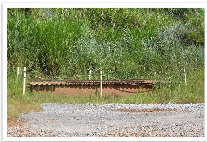
Figura 34 - Caixa SAO posto de combustível
