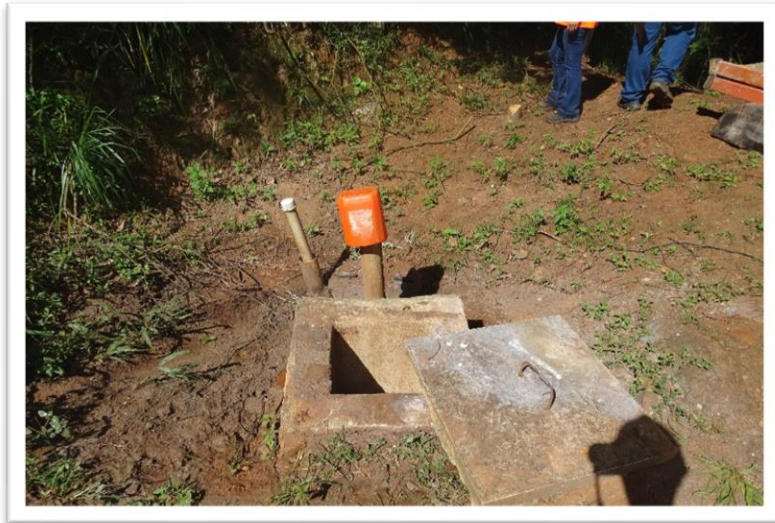
Figura 31 - Tratamento de efluentes da portaria do Paiol de explosivos
