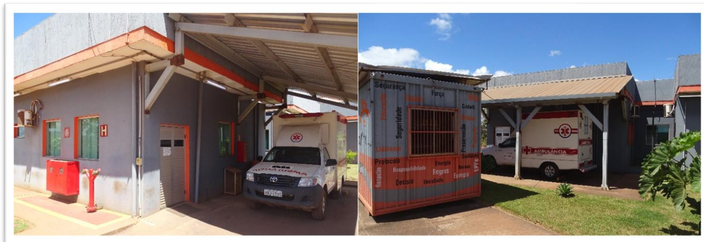
Figura 19 - Vista para ambulatório e contêiner de apoio a brigada de incêndio
