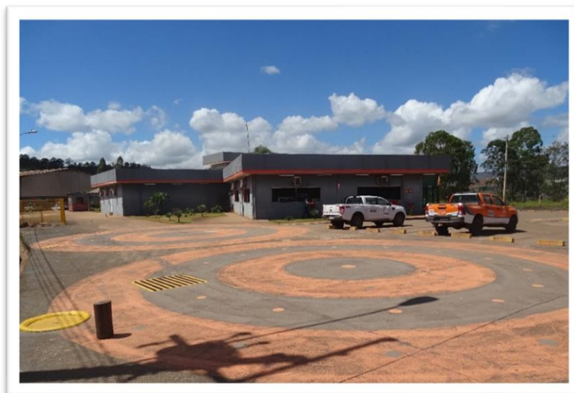
Figura 15 - Vista para o Escritório principal e estacionamento para veículos
