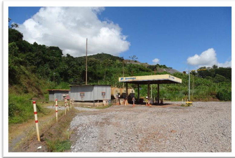
Figura 23 - Vista para área do posto de combustível
