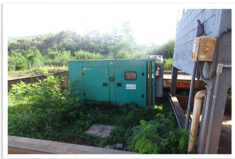
Figura 30 - Tratamento de Efluentes da portaria de 3 Antas
