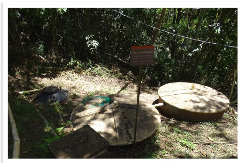
Figura 29 - Tratamento de Efluentes da portaria principal.
