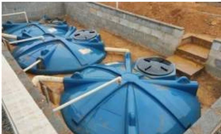
**Figura 8-26 – Tanques que acondicionam efluentes do refeitório temporariamente.**
