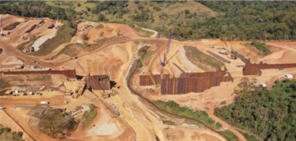
**Figura 8-14 - Imagem da obra da ECJ com estacas cravadas no terreno.**
