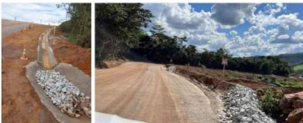
**Figura 15-33-Canaletas de drenagem em implantação no trevo de acesso da ECJ.**
