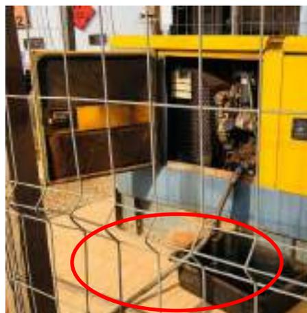
Figura 8-35 - Abastecimento do gerador utilizando bacia de contenção.
