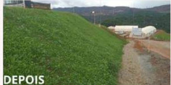
Aplicação de hidrossemeadura e biorretentores no talude do trevo de acesso a ECJ.
