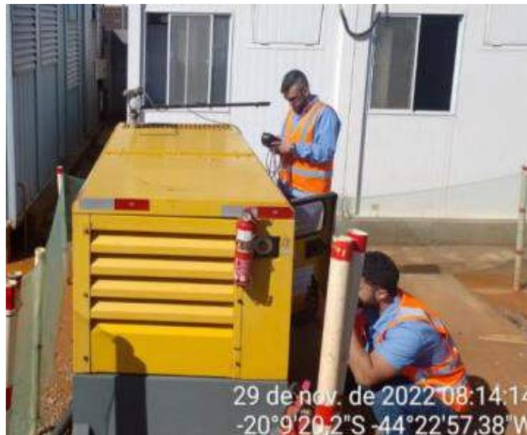
Figura 8-32 - Medição de opacidade por Opacímetro no gerado.
