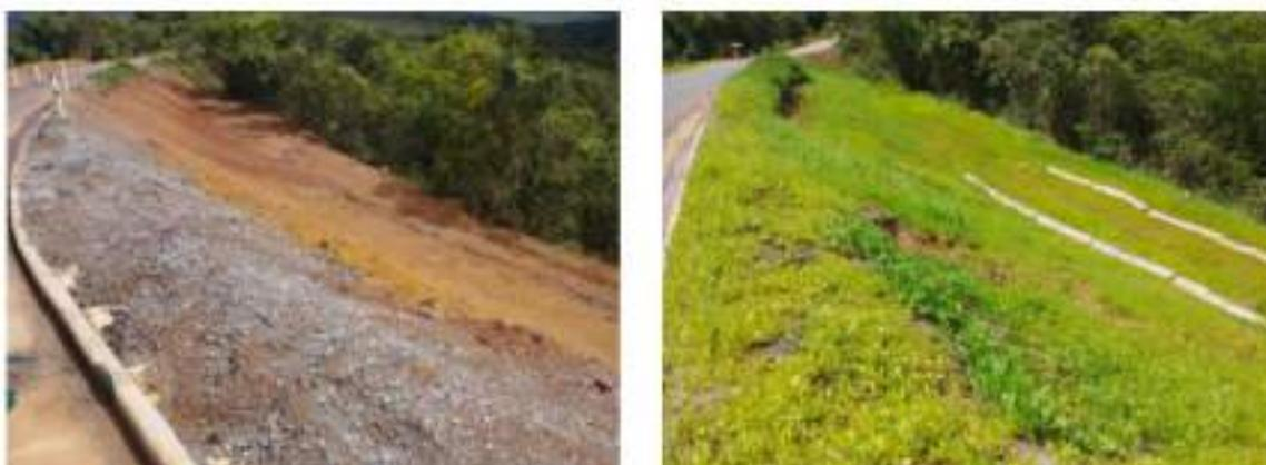
**Figura 15-27 - Aplicação de biorretentores e hidrossemeadura (antes e depois).**
