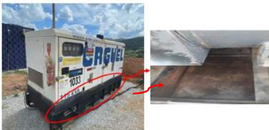
**Figura 8-34 - Gerador com bacia de contenção interna.**
