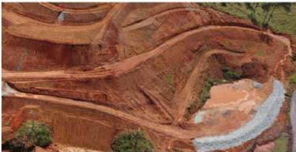
Figura 15-34-Enrocamento de pedras implantado na área de transbordo após chuva.
